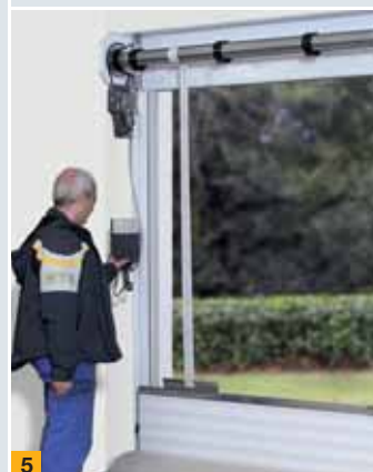
5 Přímou z palety se vrata vytáhnou na navíjecí hřídel pomocí popruhů.
